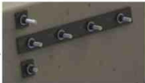
Serrage des boulons TRCC 16x120 classe 6.8: 120 N.m
